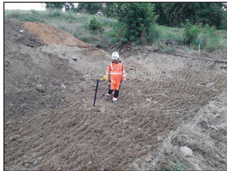
Réalisation de détection en court de terrassement
