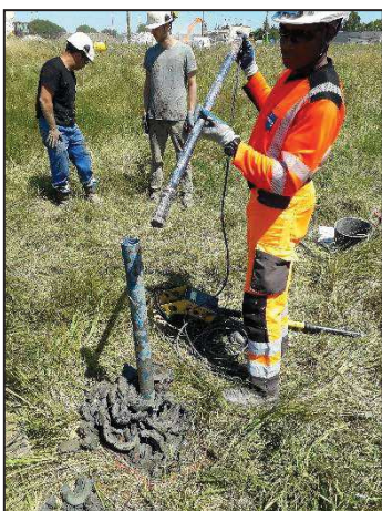
Descente de la sonde dans le PVC
