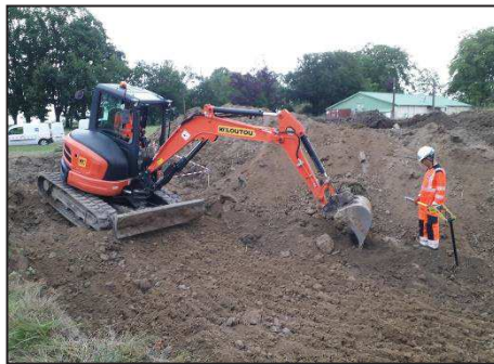
Réalisation des terrassements avec un opérateur en pied de pelle
